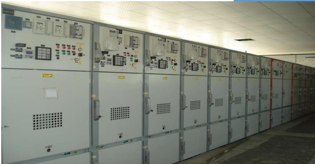
یک تابلوی فشار متوسط با محفظه فلزی و مناسب برای نصب در داخل ساختمان می‌باشد. پارسیشن‌های فلزی، محفظه‌ها را از یکدیگر جدا می‌کند و بخش‌های برق دار نیز با هوا عایق شده‌اند. این تابلو برای توزیع برق در هر نوع سیستم توزیع با جریان فیدر تا ۲۰۰۰ آمپر کاربرد دارد.
